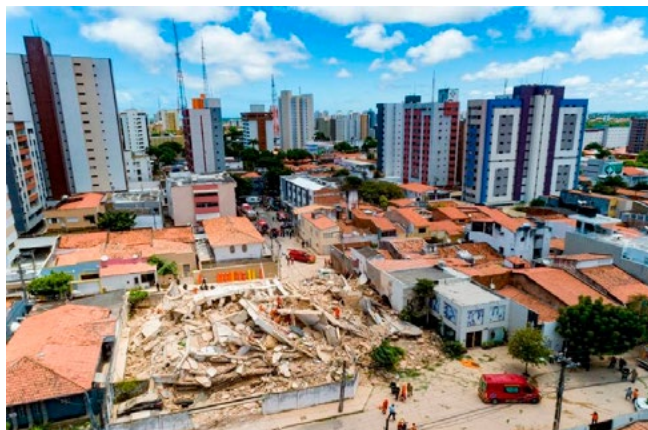
Figura 2 - Prédio que desmoronou em Fortaleza-CE
