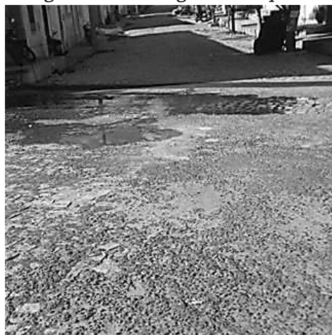
Figura 12 - Drenagem inadequada
