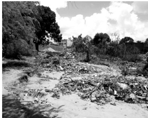
Figura 17 - Erosão na Lagoa
