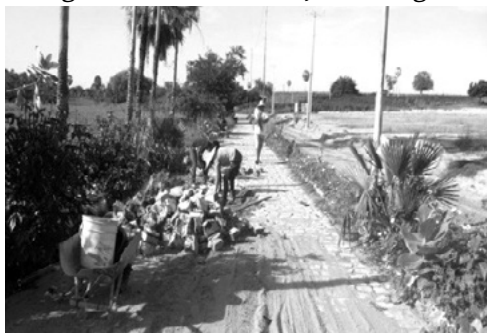
Figura 18 - Pavimentação na Lagoa
