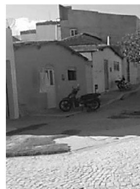
Figura 15 - Estrutura final da residência
