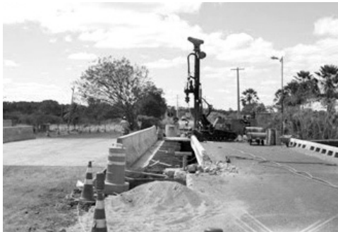
Figura 15 - Ponte nova na Lagoa
