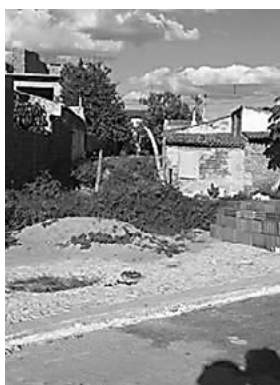
Figura 14 - Alvenaria das residências
