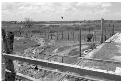
Figura 14 - Esgoto na Lagoa
