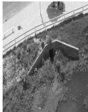
Figura 7 - Recepção de esgoto
