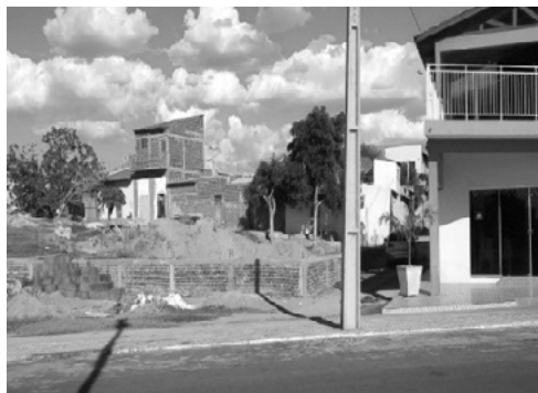
Figura 9 - Construção civil no Lagoa
