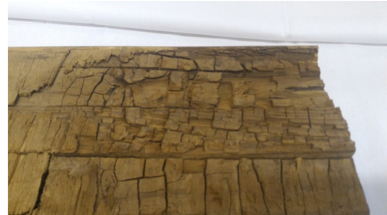
Figura 4.2. Aspecto de madeira queimada causado pelo ataque de podridão parda
