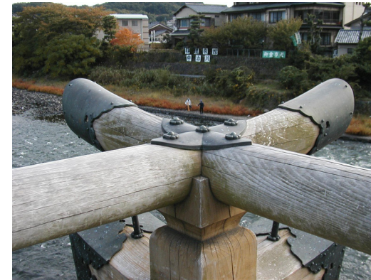
Figura 12.3. Proteção de metal para o sentido transversal de toras usadas na construção de pontes em Uji, Japão.
