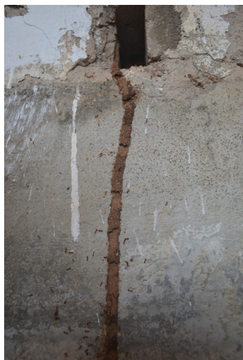
Figura 5.2. Túnel de barro construído por cupins subterrâneos em Mossoró, RN Fonte: Autoria própria (2016)
