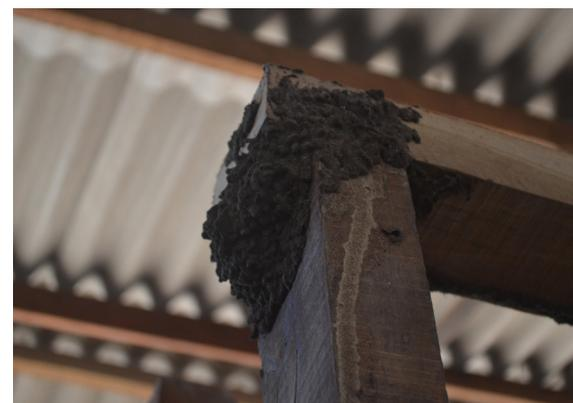
**Figura 5.4.** Ninho de cupins subterrâneos formado em estrutura de madeira úmida
