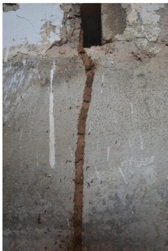
**Figura 5.2.** Túnel de barro construído por cupins subterrâneos em Mossoró, RN
