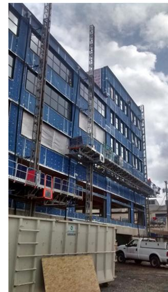
**Figura 12.4:** Vista exterior de um edifício em construção de 6 andares sendo 5 deles de madeira, desenvolvido pela Killian Pacific em Vancouver, Estados Unidos.
